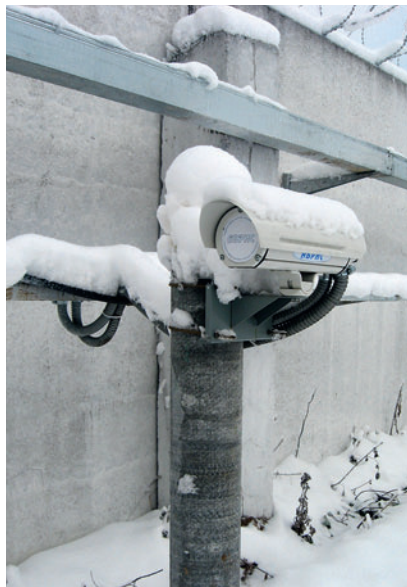
Рис. 3. Пример установки извещателя
